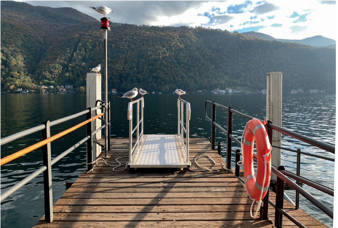
Bei der Schifffahrt liegt einer der Schwerpunkte der Sicherheitsaufsicht beim Unterhalt und der Instandhaltung der Landungsanlagen.
